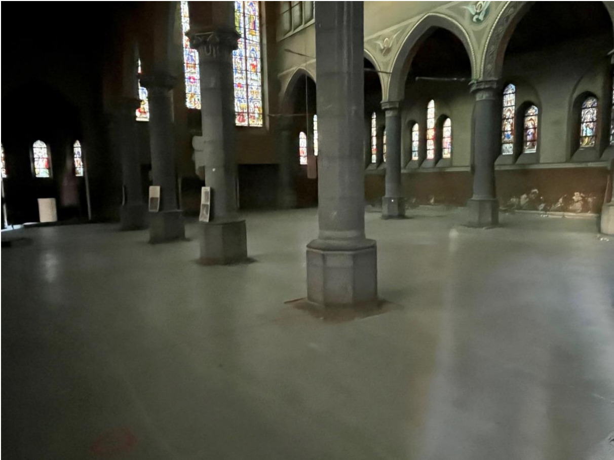
Reconstruction du sol avec une dalle en béton (décembre 2024)
